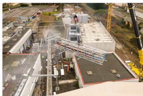
*le rack portant les tuyaux des utilités
